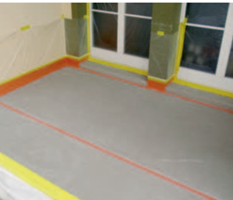
Abdichtungsmembrane Polyurethan (2mm stark, orange) mit Sandschicht...
