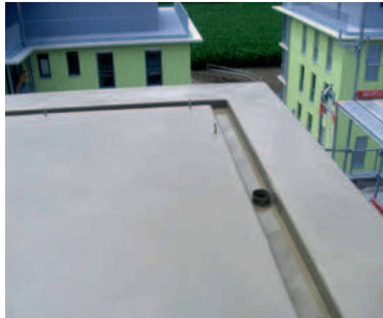
Dachabdichtung mit nahtloser Ausbildung in Wasserrinne und an Ankerstangen für Geländermontage.
