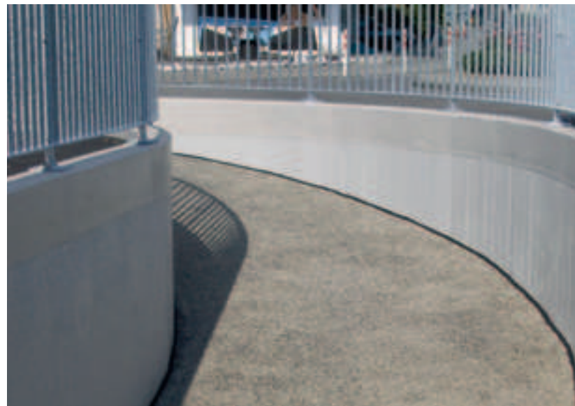
Fertig sanierte Wandflächen mit Brettstruktur, Kronenabdichtung mit Polyurethan, versiegelt.
