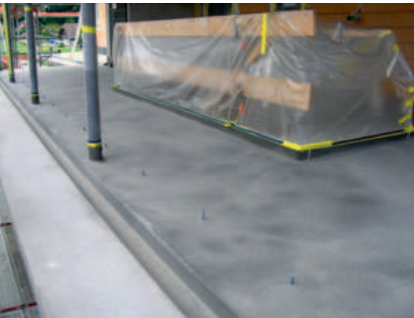
Aufbordungen, Hausanschlüsse und Dachränder sind fugenlos abgedichtet.
