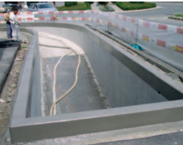
Auftragen der Polyurethan-Abdichtung im Heiss-spritzverfahren
