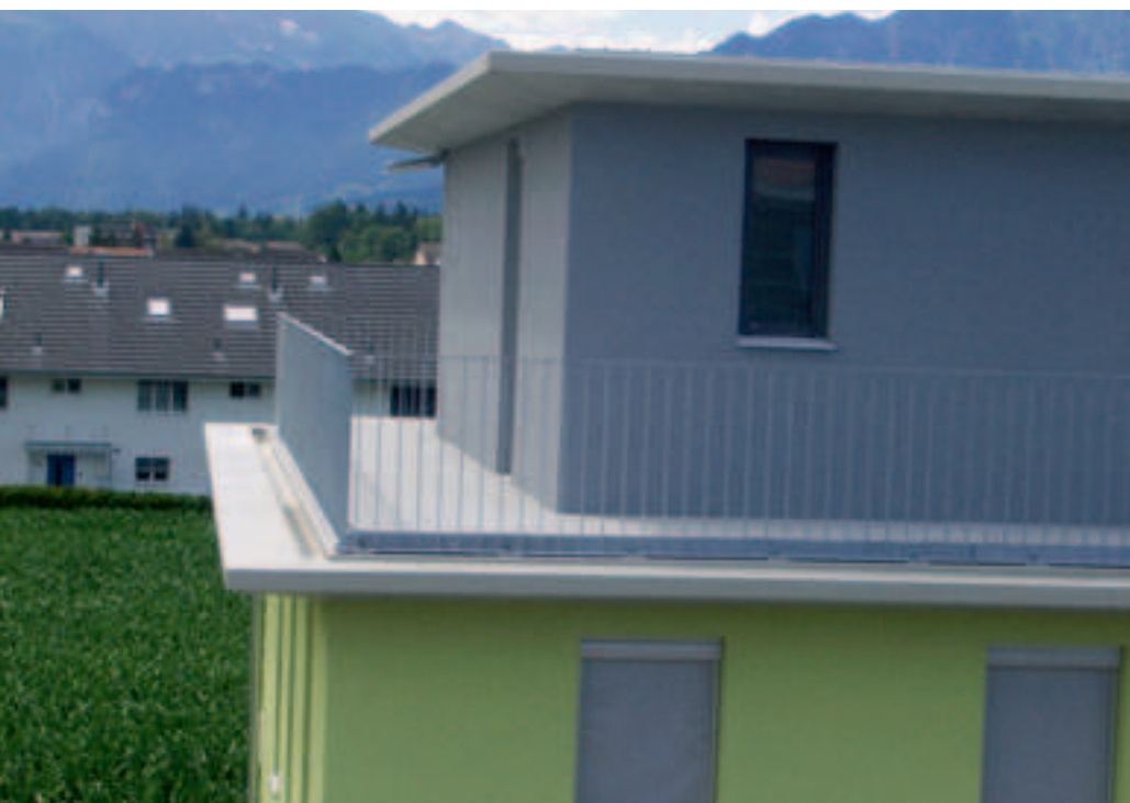
Fertig erstellter Terrassenaufbau mit sichtbarer, versiegelter Dachhaut
